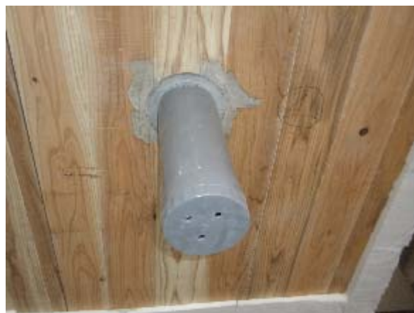
写真 3. 6. 2-30 試験体 B 仕様② 加熱側拡大
