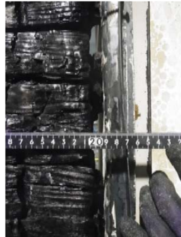
写真 3.5-10 試験体 SD1(左壁枠取合部隙間)
