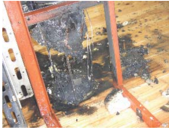
写真 3.6.4-10 試験体 A 仕様②試験後非加熱面
