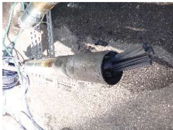
写真 3.6.4-18 試験体 A 仕様④試験後の貫通管
