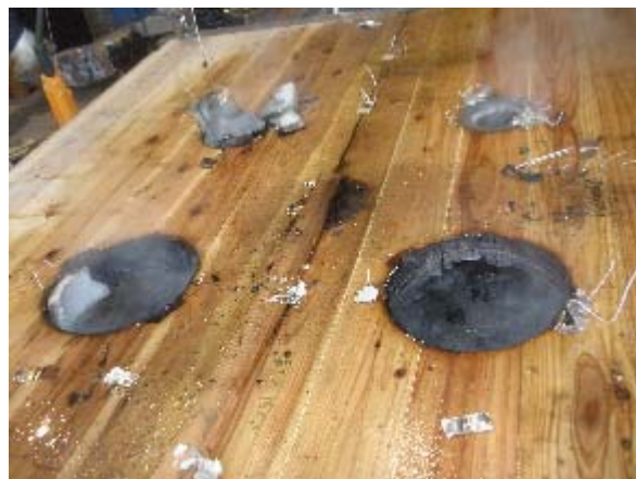
写真 3.6.4-30 試験体 B 配管を外した後の非加熱面
