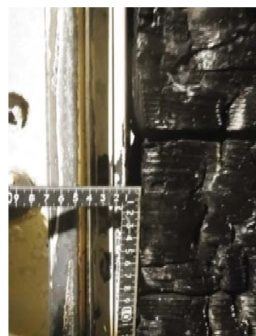
写真 3.5-12 試験体 SD1A(左壁枠取合部隙間)
