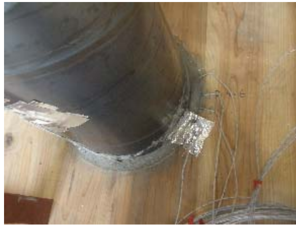
写真 3. 6. 2-32 試験体 B 仕様③ 非加熱側拡大
