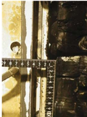
写真 3.5-9 試験体 SD1(右壁枠取合部隙間)
