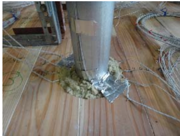
写真 3. 6. 2-11 試験体 A 仕様③ 非加熱側拡大
