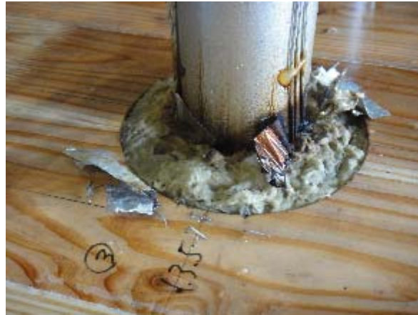
写真 3.6.4-13 試験体 A 仕様③試験後非加熱面
