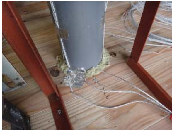
写真 3.6.2-8 試験体 A 仕様② 非加熱側拡大
