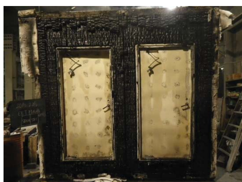
写真 3.5-3 CLT 防火設備(加熱後)
