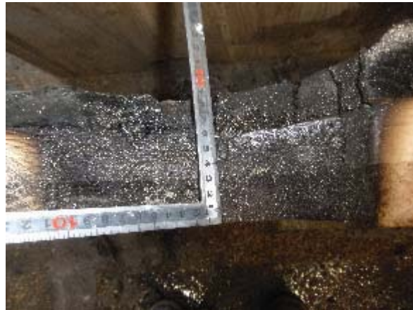
写真 3.6.4-32 試験体 B 仕様①試験後の CLT 断面
