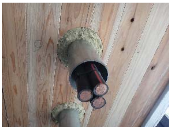
写真 3. 6. 2-21 試験体 A 仕様⑥ 加熱側拡大
