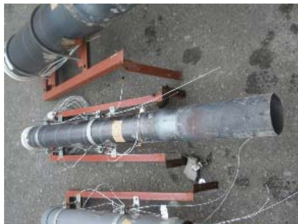
写真 3.6.4-33 試験体 B 仕様①試験後の貫通管
