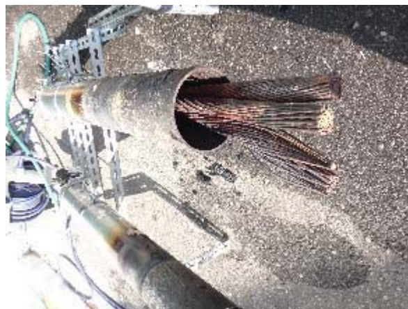
写真 3.6.4-24 試験体 A 仕様⑥試験後の貫通管
