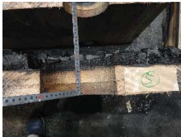
写真 3.6.4-20 試験体 A 仕様⑤試験後の CLT 断面
