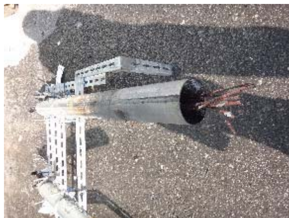
写真 3.6.4-15 試験体 A 仕様③試験後の貫通管
