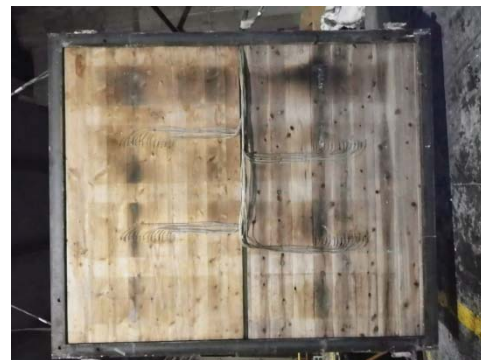
写真 3. 3. 4. (6)-4 CLT 床上試験体 (加熱後)
