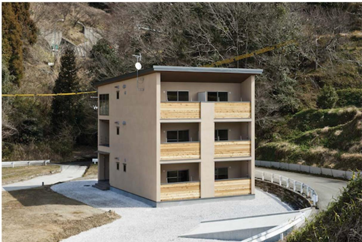
写真 1.2-1 本事業で想定する建築物の一例（3階建て社員寮、1時間準耐火構造）
