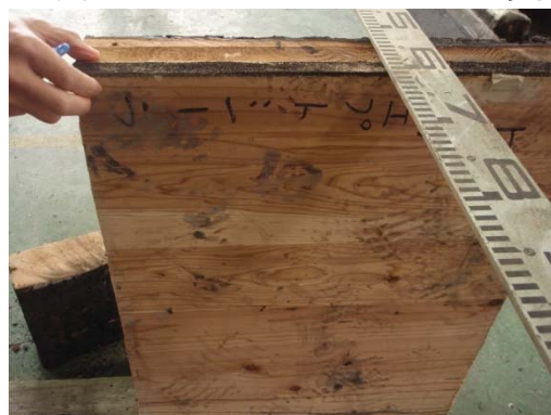
写真 3.4.1.4-18 エプトシーラーの状況
