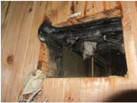
写真 3.4.3.4.(2)-5 引きボルト周辺
