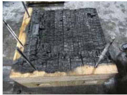
写真 3.4.3.4.(1)-8 上床接合部周辺
