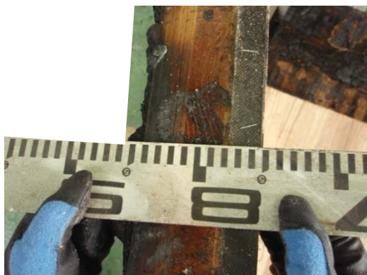
写真 3.4.2.4-19 フィブブロックの状況
