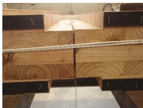
写真 3. 4. 1. 2-4 目地処理スギ合板用欠込み
