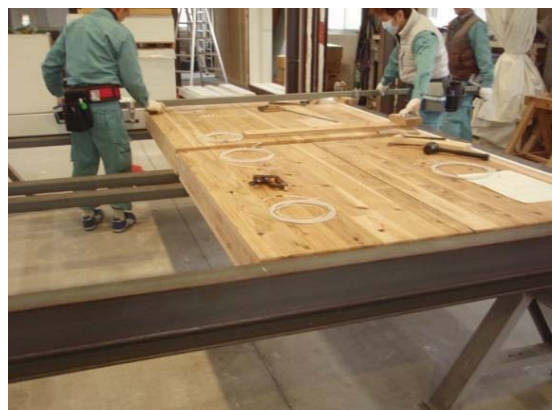
写真 3. 4. 1. 2-5 試験体作成状況
