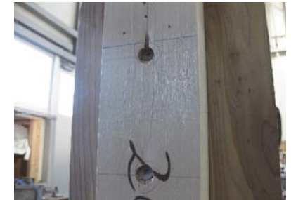
写真 2-3-2-10 TSS-L85 ビス頭めり込み ビスの変形
