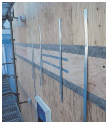
写真 2-3-1-1 枠組壁工法金物に使用される金物 (釘接合) の例
