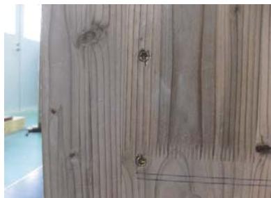
写真 2-3-2-14 TSS-L290 ビス頭のめり込み ビスの変形、引き抜け
