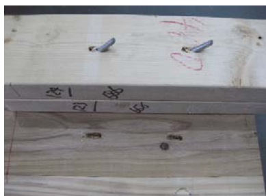
写真 2-3-2-16 TSS-L135 ビス頭のめり込み ビスの変形、折損、引き抜け
