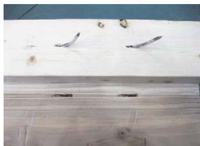
写真 2-3-2-11 TSS-N90a くぎの変形
