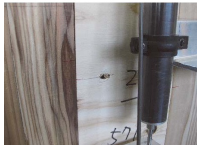
写真 2-3-2-4 FSS-N75 くぎ頭のめり込み くぎの引き抜け、変形
