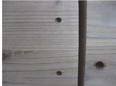
写真 2-3-2-7 FSS-L290 ビス頭めり込み その他、ビスの変形、CLT 材相互の離間
