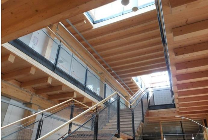
照明や電気配線は露出させ、梁や天井部分に綺麗に配線されメンテナンスがしやすいようになっている
