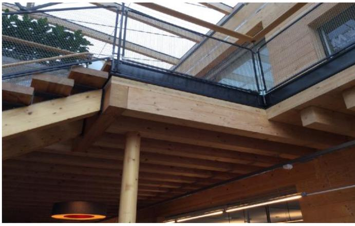
建物内部:床、壁の構造材はCLT
