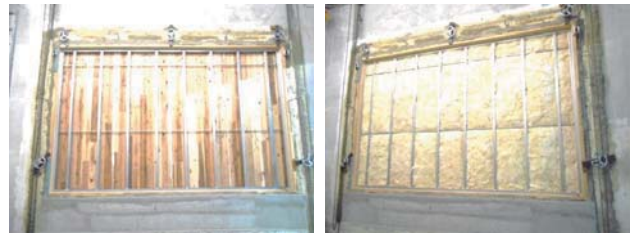
界壁遮音性能測定試験体
