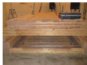
天井CLT仕上材
