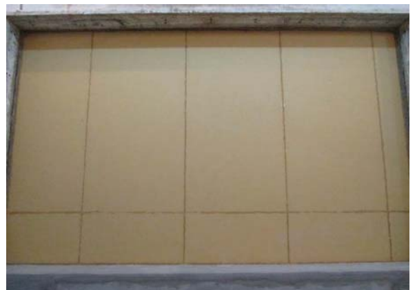
(6) 上張りPB(9.5mm)の設置状況 (音源側)
