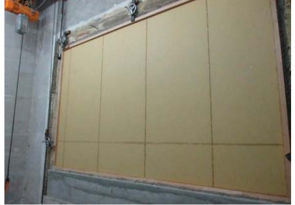
(2) 上張りPB(9.5mm)の設置状況
