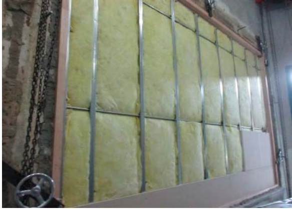
(1) 下張り強化PB(21mm)の施工状況
