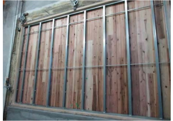
(2)LGSの取付状況
