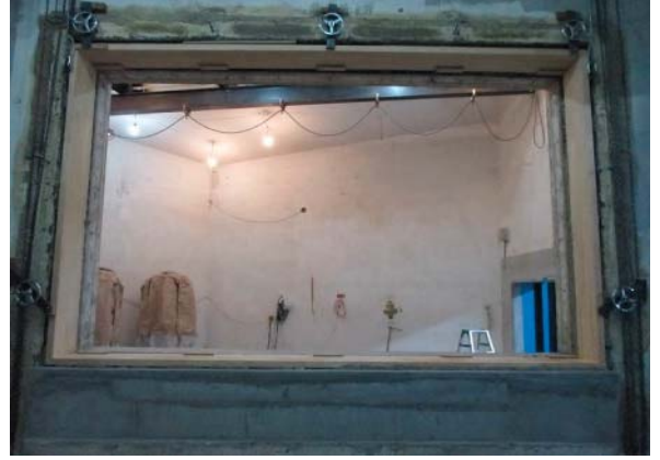
(2) 四周木枠の取付状況
