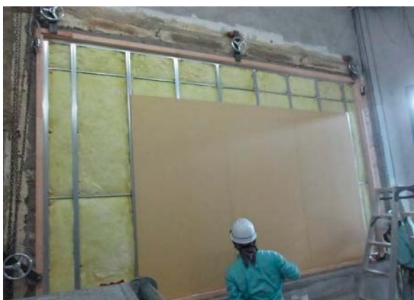
(5)下張りPB(12.5mm)の施工状況
