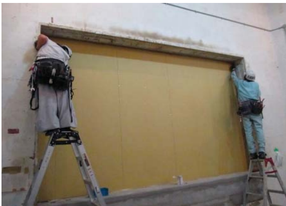
(5) 下張りPB(12.5mm)の設置状況 (音源側)
