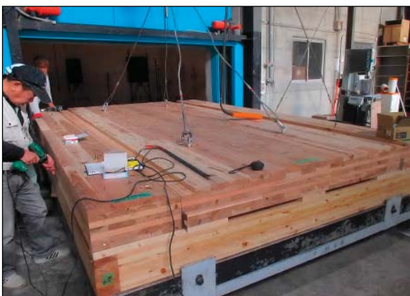
(5) 床CLTパネル(t=210)の設置
