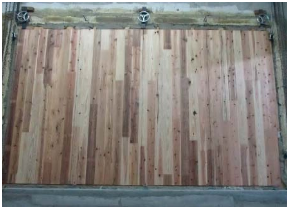
(3)CLTパネル(t=90mm)の設置状況
