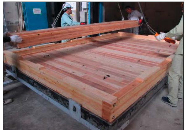
(4) 床CLTパネル(t=210)の搬入
