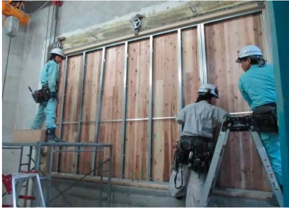
(1)LGSの施工状況
