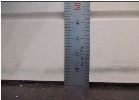
(3) 幅木の設置状況(試験体No.2-1)
