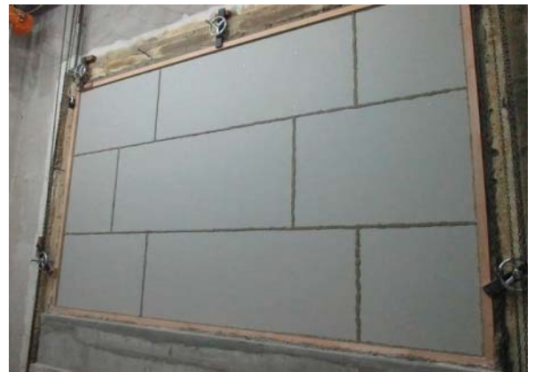
(4) 上張り硬質PB(9.5mm)の設置状況
