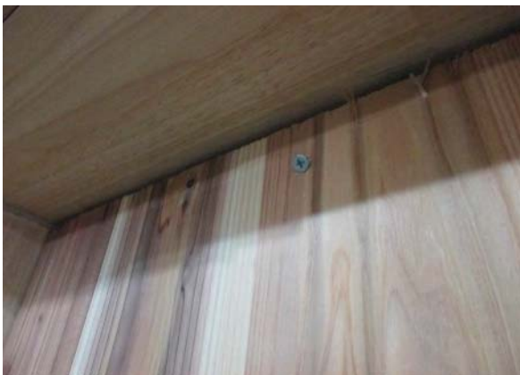
(5) CLTパネル(t=150mm)と木枠のビス留めの状況
