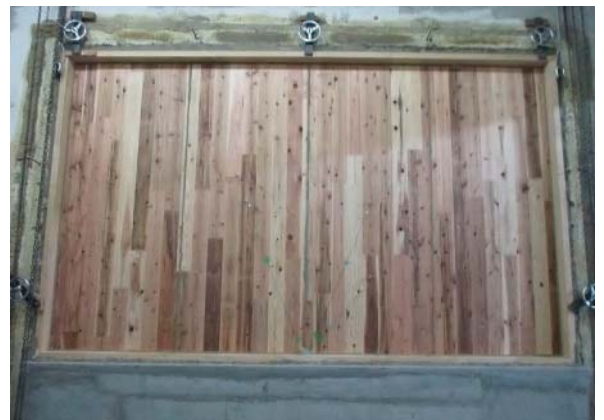
(6) CLTパネル(t=150mm)4枚の設置状況
