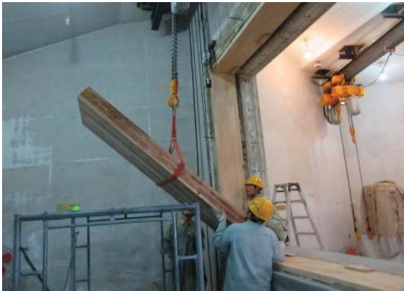
(3) CLTパネル(t=150mm)の取付状況
