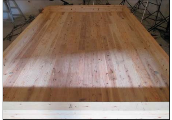
(2) 試験体No.0-1の設置状況
