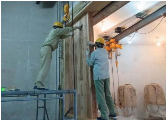
(3) CLTパネル(t=150mm)の取付状況
