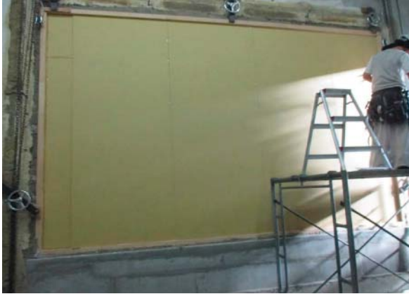
(1) 上張りPB(9.5mm)の施工状況
