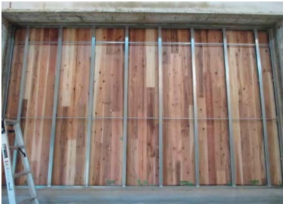
(3) LGSの取付状況(音源側)
