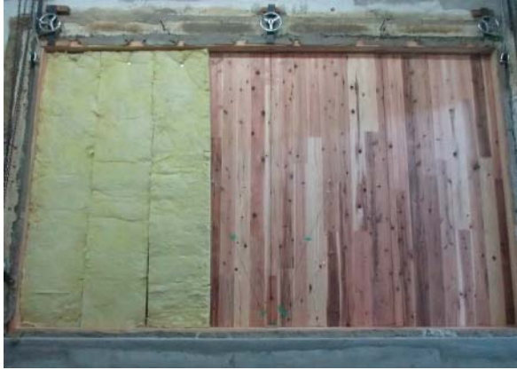
(1)GWの施工状況
