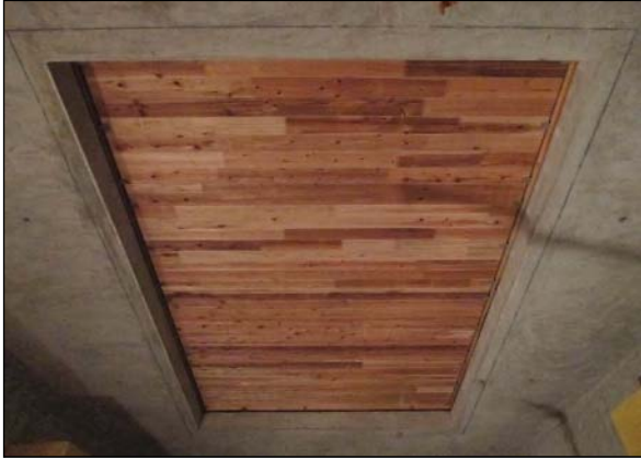
(1) 試験体No.1-1の設置状況 (床下側より)
