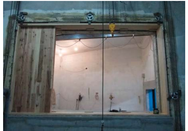
(4) CLTパネル(t=150mm)の取付状況
