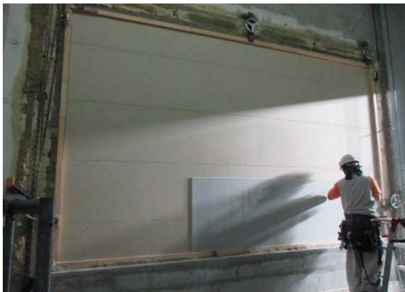
(3) 上張り硬質PB(9.5mm)の施工状況
