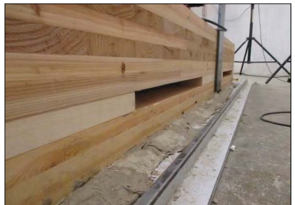
(6) 上階側の四周空気抜きの様子(試験体No.1-4)
