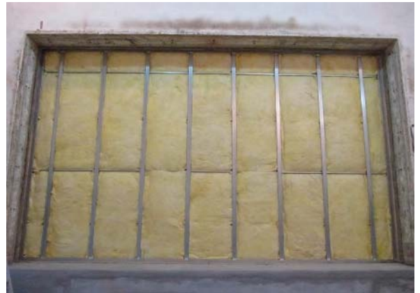
(4) GWの取付状況(音源側)
