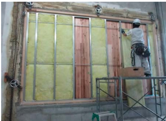
(3)GWの施工状況
