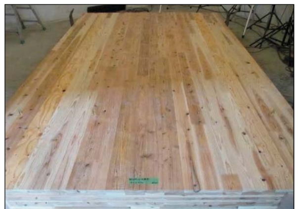
(6) 床CLTパネル(t=210)の設置状況
