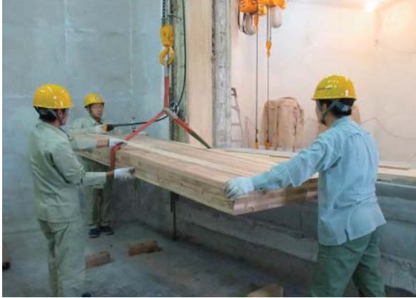
(1) CLTパネル(t=150mm)の取付状況
