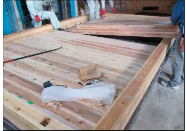
(2) 天井CLTパネル(t=90)の搬入
