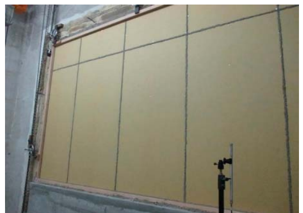
(6)下張りPB(12.5mm)の設置状況
