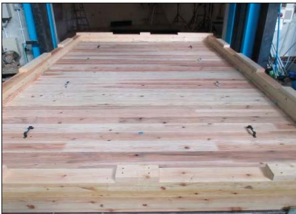
(3) 天井CLTパネル(t=90)の設置
