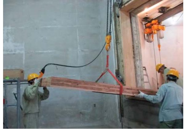
(2) CLTパネル(t=150mm)の取付状況
