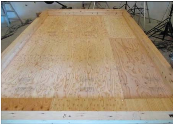
(3) 試験体No.0-2の設置状況
