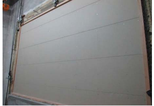
(2) 下張り強化PB(21mm)の設置状況
