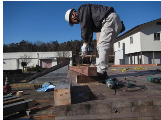
図 3.25 404 材を CLT 床版にビス留め
