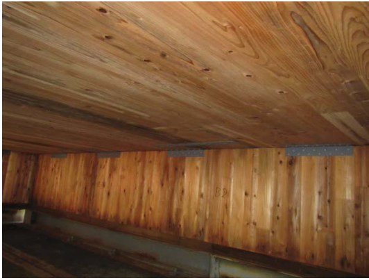
図 3.28 北見モデル:CLT 床版どうしを 帯金物でビス留め
