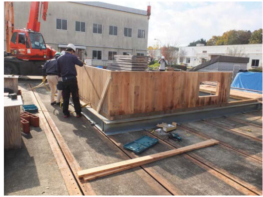
図 3.17 CLT 壁 (CLT、3層3プライ)
