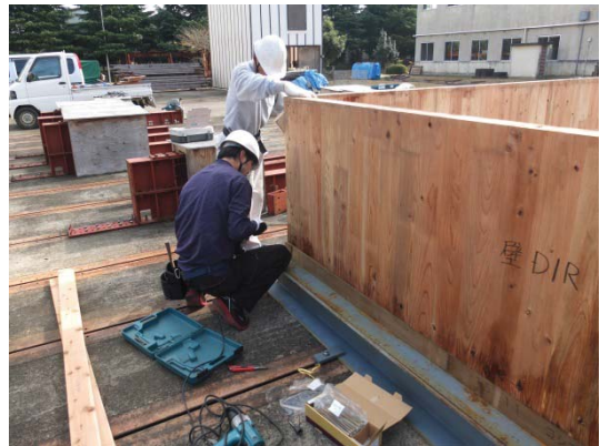
図 3.19 壁は土台に斜めビス打ちで固定
