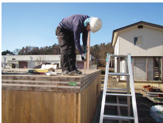
図 3.38 勝どきモデル：CLT 床版にビス 平打ち
