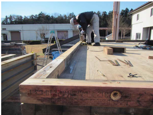
図 3.50 森林総研+ \alpha モデル：404材を ビス留め
