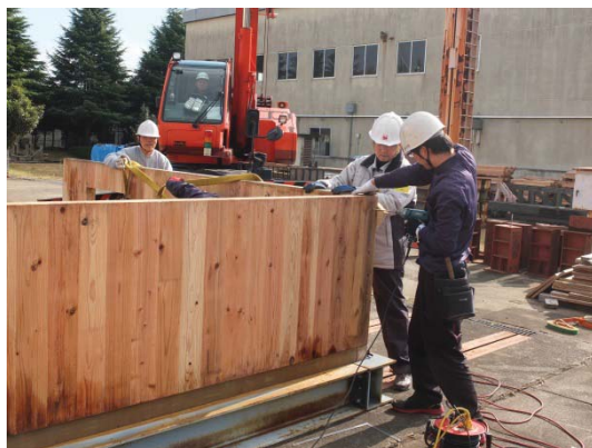
図 3.20 壁のコーナー部分はビス平打ち
