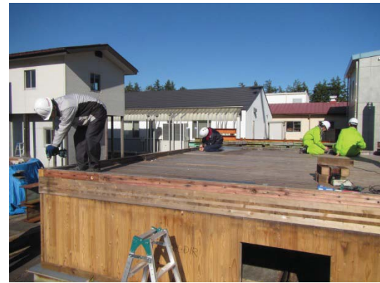
図 3.37 404 材と L 形金物を外す
