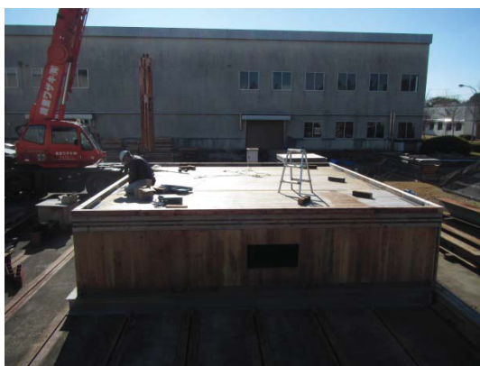
図 3.26 北見モデル : L 形金物を 404 材と CLT 床版にビス留め
