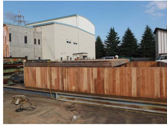
図 3.23 CLT 床版 (5.5m×2m) 2 枚目を壁に載せる
