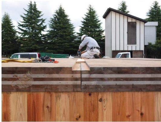
図 3.24 スプライン (28mm 厚構造用合板) をビス留め
