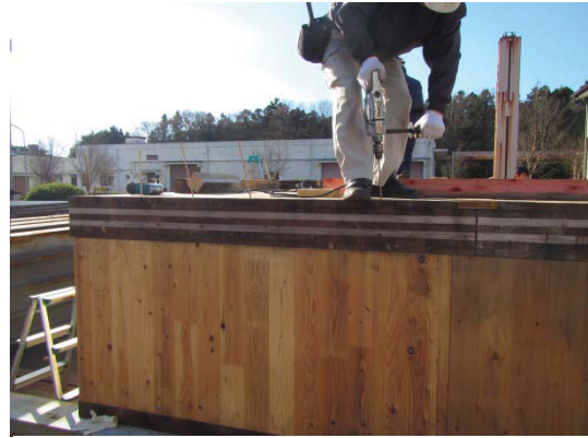
図 3.49 森林総研+ \alpha モデル：床から 壁へ平打ちしていたビスを取りはずす
