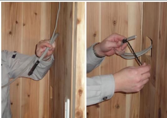
強電ケーブル2本を束ねて、中央よりの入線孔より試行。少し固めで力がいるが、問題なく入線可能。スイッチ孔にて分離して、コンセントまでの配線を更に送り込む。
