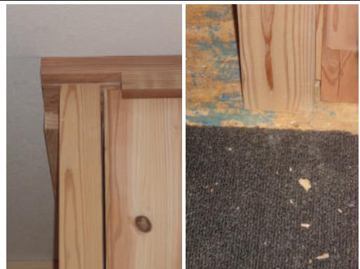
end ポール部の写真。左が上部、右が下部。パネルの傾きで上部に隙間が生じた。
