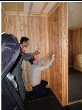
スイッチ、コンセントの取付け用開口部の形状と位置を計測して確認。
