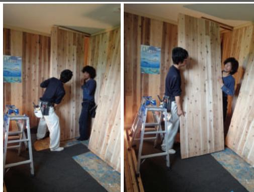
単独T型パネルを引抜く。取り付け時に比べ、取り外しは容易。
