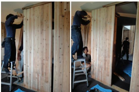
1枚目のパネルを取り外す。パネル小口、上下2カ所に手がかりとなる角材をビス止めし、2人で同時に引っ張るとスムーズに引抜ける。
