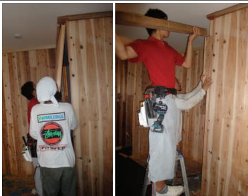
クランク部に最後のパネル「9ssPW=838」を建て込む。床の糊、上部ランナーパッキンとの摩擦があり掛矢を使う。
