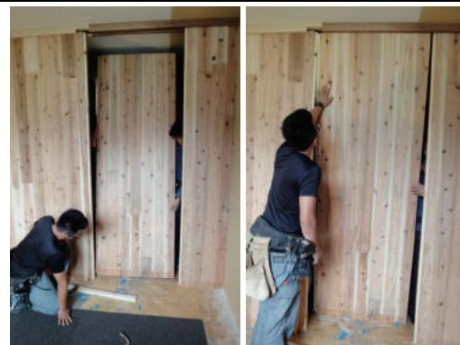
2枚目のパネル「9ssPW=838」を立て込む。手前側で補助しながら、向こう側と2人でつり込む。
