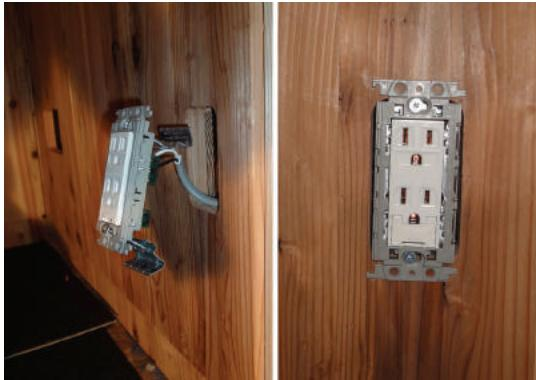
コンセントに配線し、挟み込みプレートを使って壁に固定。
