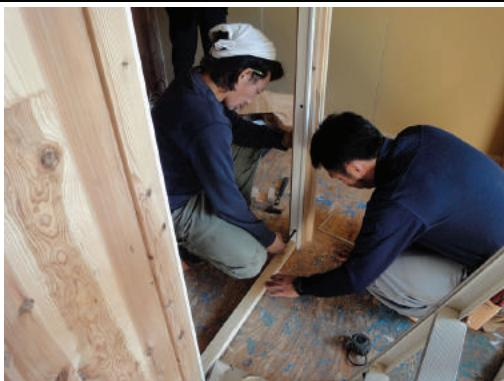
ドア枠の内法寸法の微調整は、戸先枠に組込まれている出入り調整機構を使って行う。±3mm の調整が可能。
