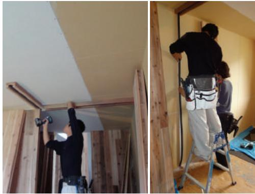
天井面に上部ランナーを取り付け、X07 通り壁に雇い実とゴムパッキンを取付ける。
