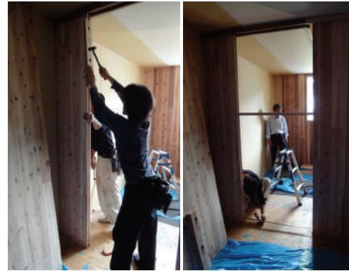
端部パネル「ePW=416」を建て込む。隣のパネルとの間を角材で保持して位置を出し、ビスにて固定。
