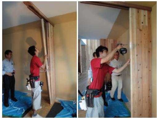
X07 通り、1枚目のパネル「ePW=416」を建て込む。床面の糊が抵抗になってパネルの滑りが悪い。壁雇い実面のゴムパッキンの弾力が強く、パネルを押し付けながらビス止めして固定。
