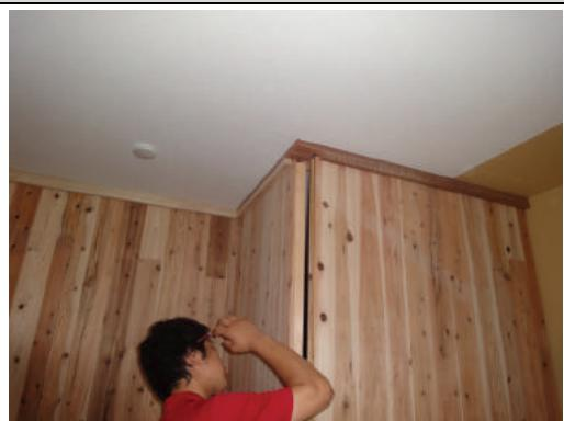
最終パネル「9ssPW=838」建て込み完了。上部に隙間が生じたのは床墨と天井墨のズレからパネルに傾きが生じたため。コーナー部は特に墨出しに注意が必要。
