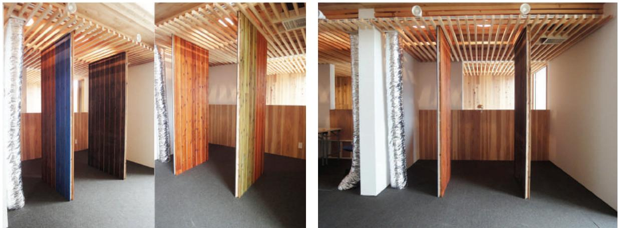
CLT 間仕切りパネルの両面に塗装と溝加工を施した試作体は、塗装面が両面とも確認できる室の中央に展示した。幅 6 mm × 深さ 6 mm の溝がリズムを刻み濃い色も軽快に感じられる。2 色の塗り分けは目地を境とすることでムラなくシャープに仕上がっている。
