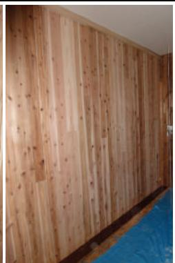
両側とも床面にフローリングを1枚張り込む。遮音試験の際に床と接する部分の条件を住宅時と同じ条件にする。
