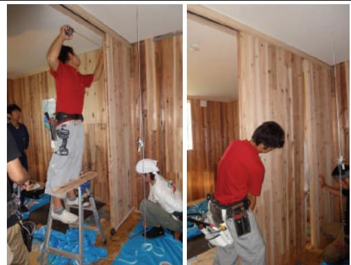
X07 通り側、2枚目の「9sPW=871」を建て込む。摩擦抵抗があり動きが悪い。掛矢を使う。CLT 厚 61 mm、上部ランナー溝 59.5 mm／雇い実 40 mm、CLT 溝 39.5 mm。
