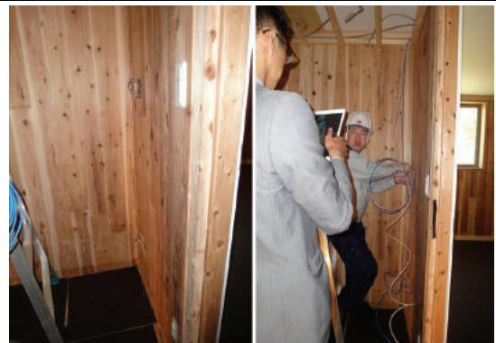
左は強電ケーブル入線完了時。続けて、弱電ケーブルも2本まとめて挿入。
