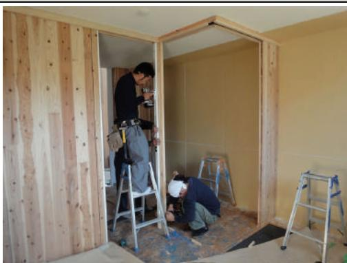
戸先枠の出入り調整機構により、枠の内法を調整してドア枠のセットが完了。
