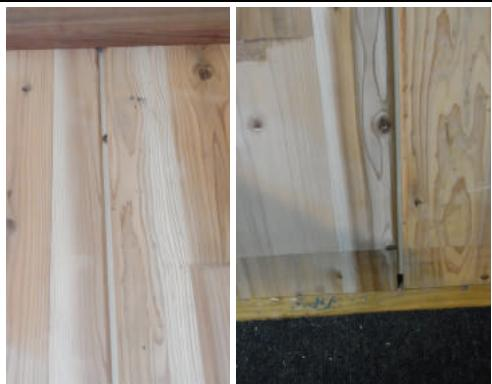
R面取りした 6 mm 目地は、パネルの目違いを目立たなくする効果があり、仕上がりも良い。面は 3 mm と 6 mm を作成したが、3 mm で十分効果がある。幅木の納まりが良い 3mm を採用とする。
