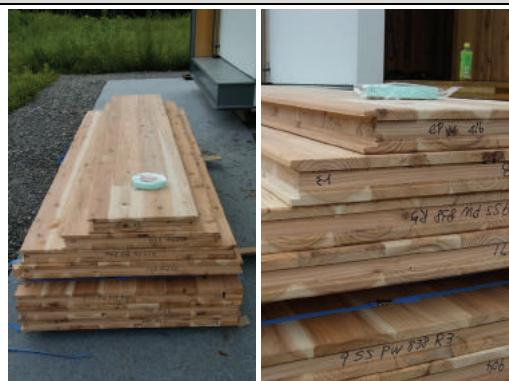
CLT 間仕切り壁パネルは銘建工業にて製作・加工。小口にパネル符号を表示。
