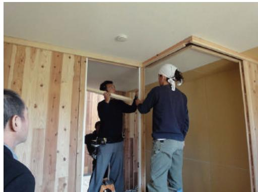
ドア枠の内法寸法に合わせて定規となる角材を用意し、枠内の寸法が適正となるようにコーナー方立ての位置を調整する。
