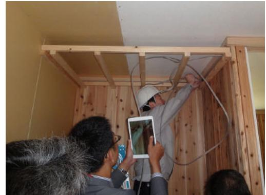
配線パネル B にケーブルを入線。強電ケーブルを2本別々に角の入線孔から挿入を試みるが、2本目のケーブルがうまく入っていかない。
