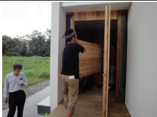
幅 900 mm のパネルは2人で運搬。… 気乾比重 0.4 として 52kg/枚。
