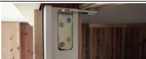
上部ヒンジは、ドア取付け部の樹脂部材(白色)が間仕切りの上部ランナーにちょうど納まる。
