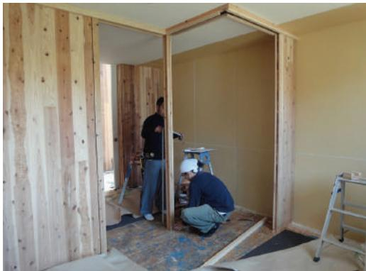
ドアユニットと配線パネルの間のコーナー方立てを設置。ドアの幅寸法と配線パネルの納まりの双方に注意して建てる込み。
