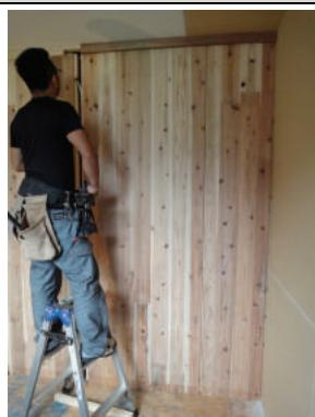
分割柱を取付ける部分の位置調整。
