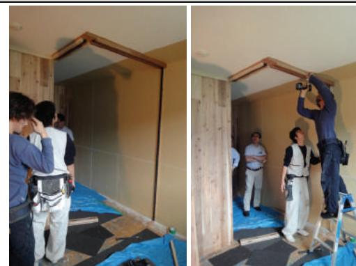
上部ランナーを取り外し、端部をカットして新設部分の上部ランナーとして再利用する。
