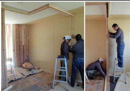
壁面に端部雇い実を取り付け、end パネル ePW=416
