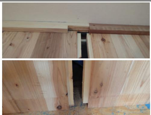
分割柱を取付ける部分の上下詳細。この状態から下部ランナーを差し込むのは難しい。あらかじめパネルの溝に入れておくのが良い。
