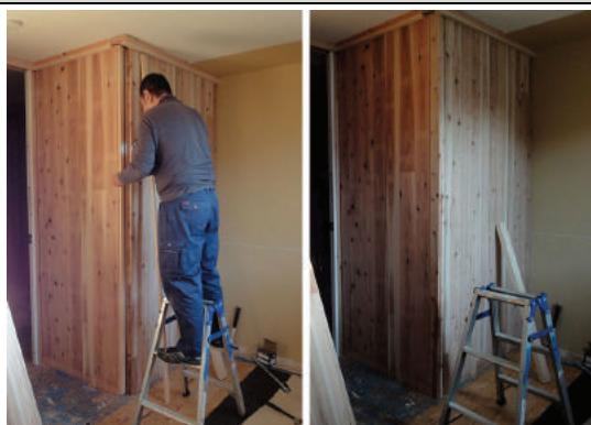
パネル出隅にend ポールを取付けて、CLT 壁パネルの建て込みを完了。
