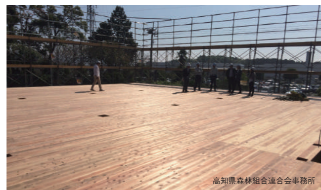
床や屋根の大きなフラットの面にCLTを使うと、大版パネルの特徴を活かした効率的な施工が可能となり、コストメリットが出やすく、工期の短縮にもつながる
