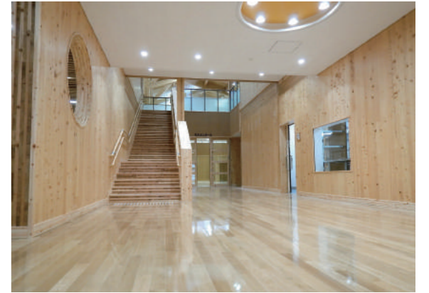
準耐火構造の燃えしろ設計により現しとしたCLT壁。くり抜くことも可能
