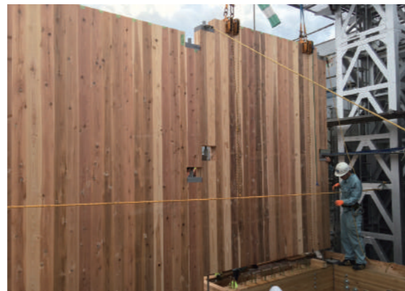
事前のせん断耐力実験から決まったCLTとはりとの接合方法(GIR)
