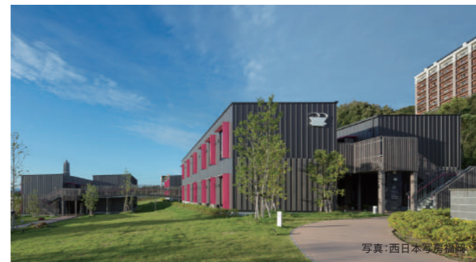
繰り返しの平面計画となるホテルはCLTパネル工法の特徴を活かしやすい
