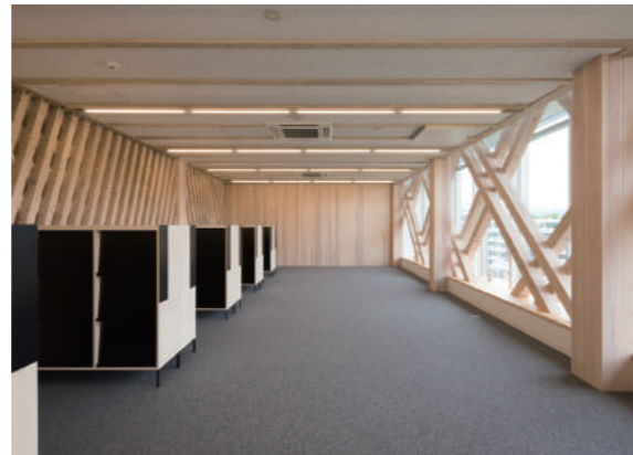
耐火の規制がかからない鉛直力を支持しない間仕切壁にCLTを使用
