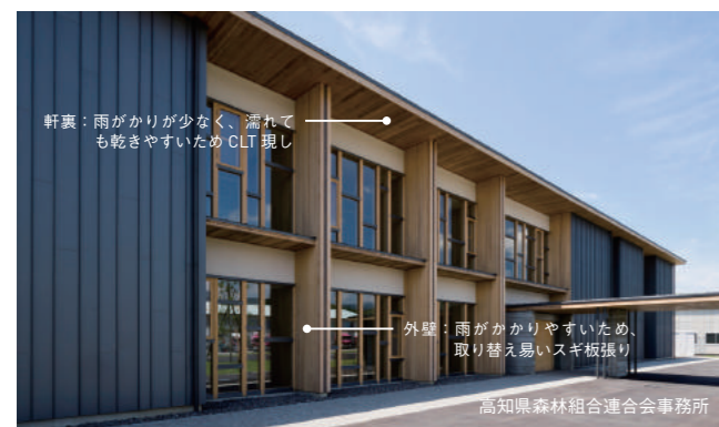
雨がかりのある部位を、木材仕上げとする場合は、腐朽や表面劣化が生じる可能性があるため、CLT等の躯体は現しにせず、仕上げの木材を取り替え易いディテールで張るとよい
