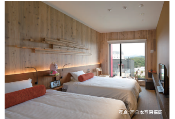
天井を準不燃材とすることで壁面のCLTを現しとした客室
