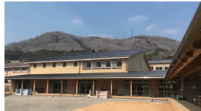
それぞれの建物を単純な形態としCLTを適材適所に使用
