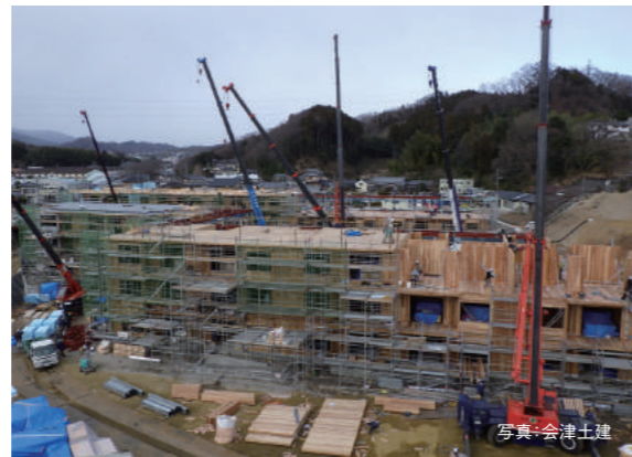
クレーン設置スペース、CLTパネルの仮置きスペースがあると施工しやすい
