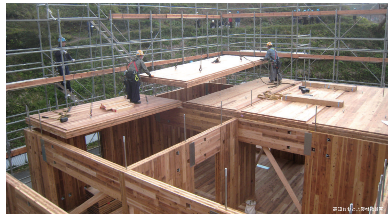
CLTを壁式のプレキャストコンクリート造のように壁・床・屋根に使う“CLTパネル工法”
