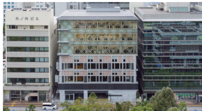
CLTを4~6階の高耐力耐震壁に使用し開放的な空間を実現
