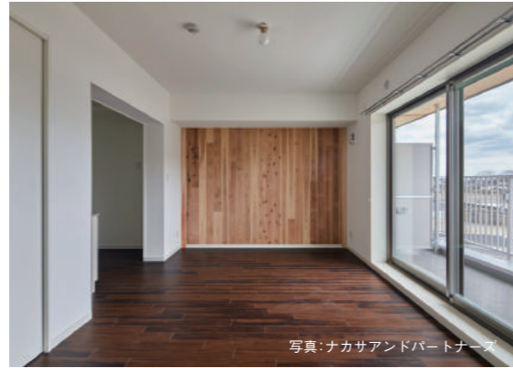
準耐火構造の燃えしろ設計により現しとしたCLT壁。躯体と仕上げを兼ねる
