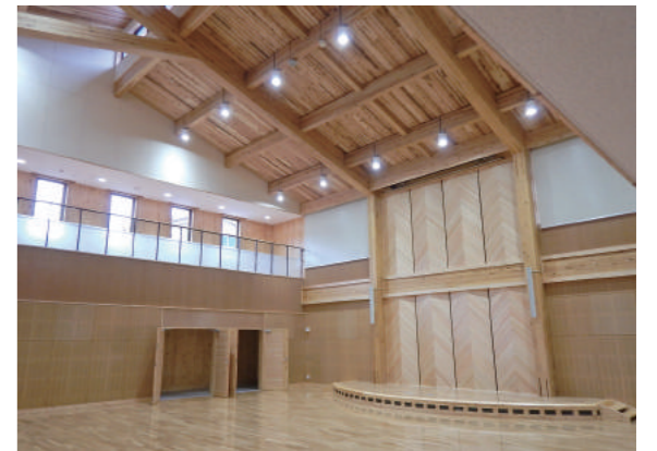
大断面集成材によるラーメン架構の屋根の野地板にCLTを使用
