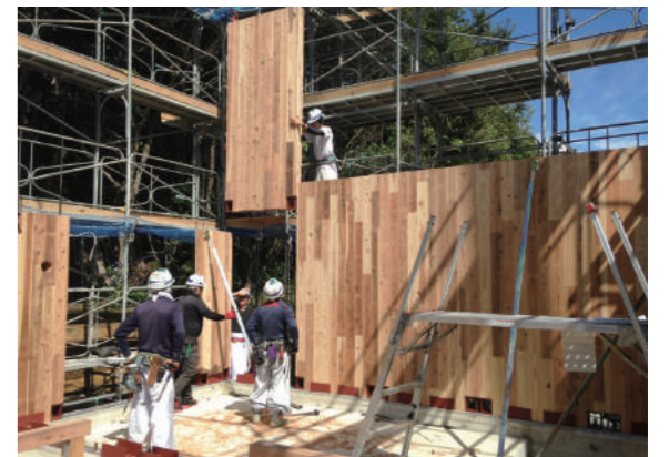
CLTパネルは予め工場でプレカット加工し金物と複合して建て方を行う
