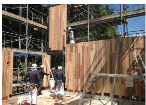
CLTパネルは予め工場でプレカット加工し金具と複合して建て方を行う
