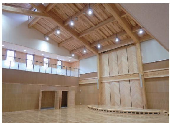
大断面集成材によるラーメン架構の屋根の野地板にCLTを使用
