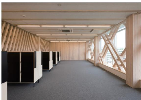
防耐火の規制がかからない鉛直力を支持しない間仕切壁にCLTを使用
