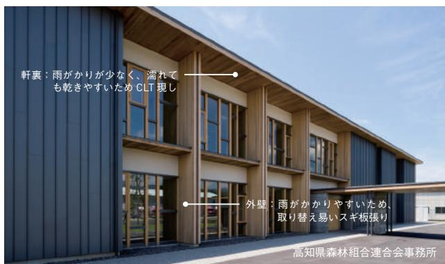
雨がかりのある部位を、木材仕上げとする場合は、腐朽や表面劣化が生じる可能性があるため、CLT等の躯体は現しにせず、仕上げの木材を取り替え易いディテールで張るとい
