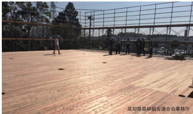
床や屋根の大きなフラットの面にCLTを使うと、大版パネルの特徴を活かした効率的な施工が可能となり、コストメリットが出やすく、工期の短縮にもつながる
