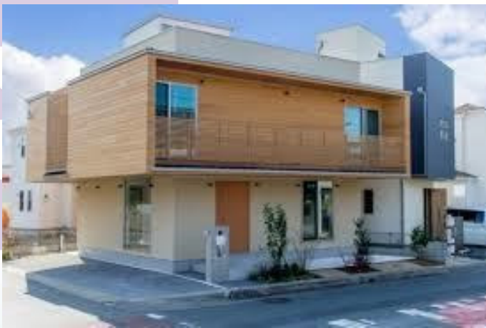
二方向はね出しオーバーハングの実例
