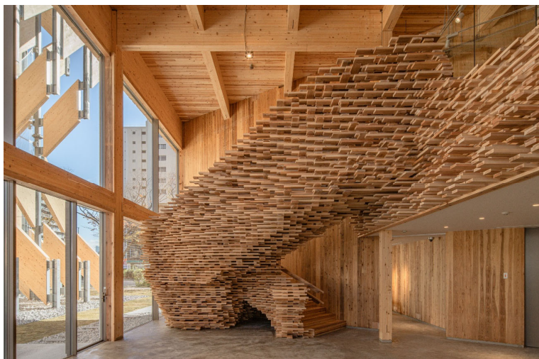
▲「屋内展示棟 A 棟」吹き抜けの階段の木組み細工
