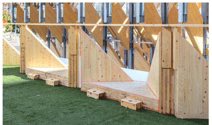
▲テラスの手摺で使用されている端材
